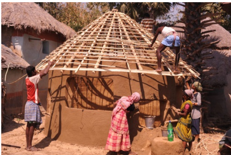
屋根の構造をつくる。壁の表面に牛糞のを加えた土を何層も塗っていく。
