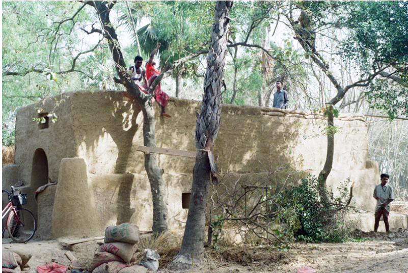
上から粗壁用の土を塗ってい
