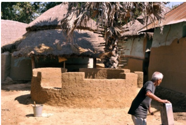
土を積み上げていく
