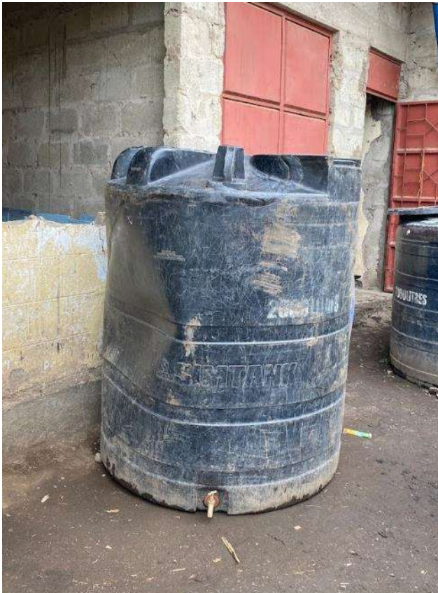
使えない貯水タンク
